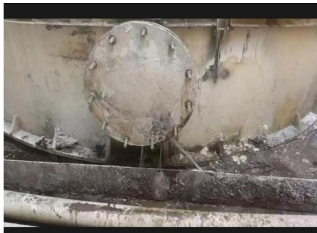
图 2 中浸上清液储罐人孔
